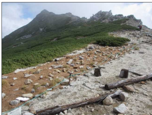
完了した作業地
