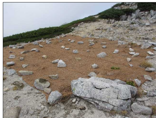
完了した作業地
