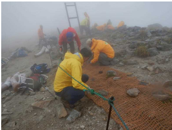
植生マット敷設1
