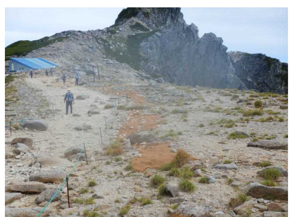
作業実施後の状況
