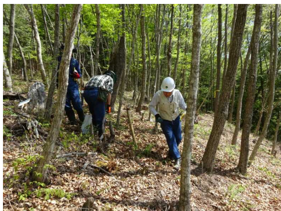
電気柵の設置作業（城山国有林）
