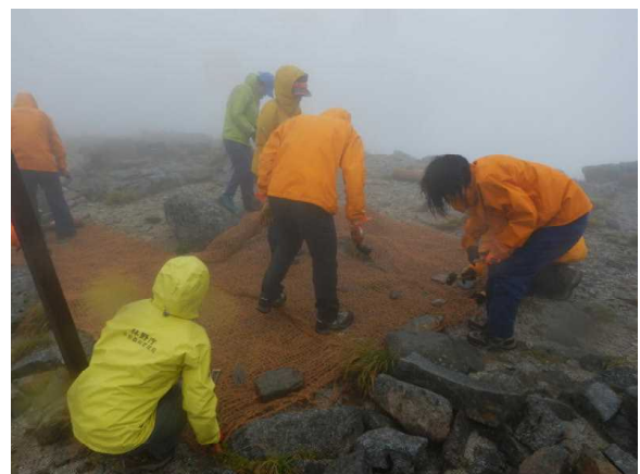
植生マット敷設2
