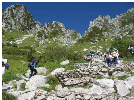
資材の運搬状況（9月15日）
