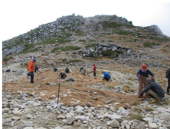
植生マット敷設の状況（10月1日）
