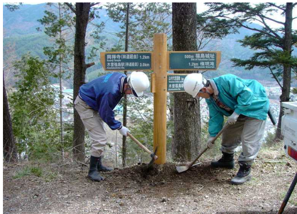
案内標識の設置 (平成17年4月23日)
