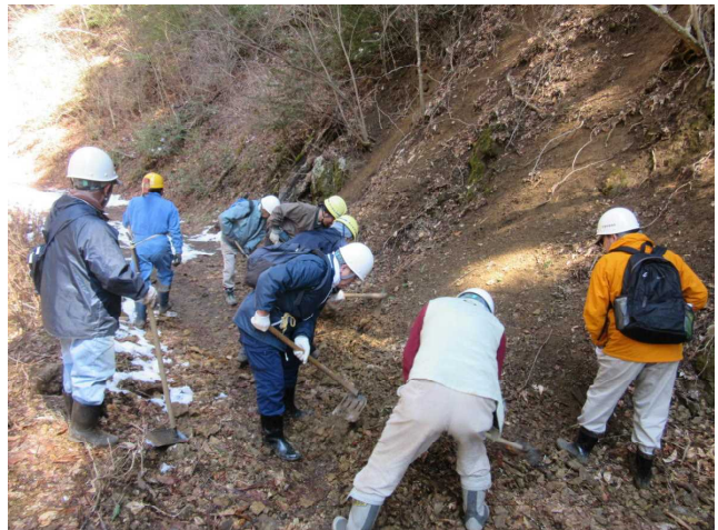
林道崩土除去作業
