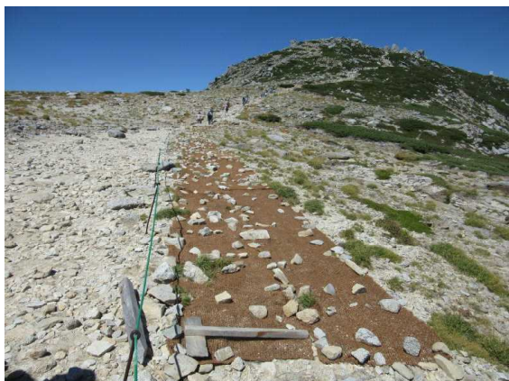
作業実施後の状況
