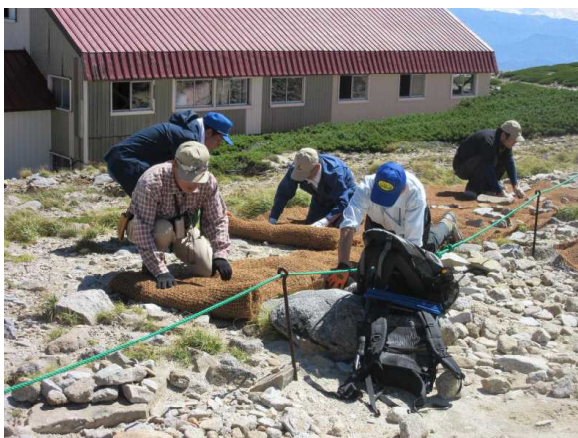
植生マットの敷設
