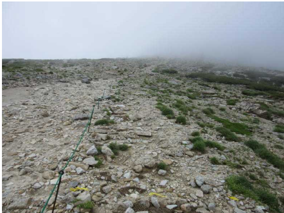
作業着手前の状況（7月27日）
