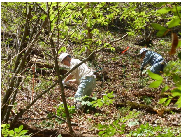
電気柵の設置
