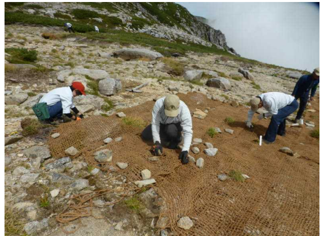
植生マット敷設作業
