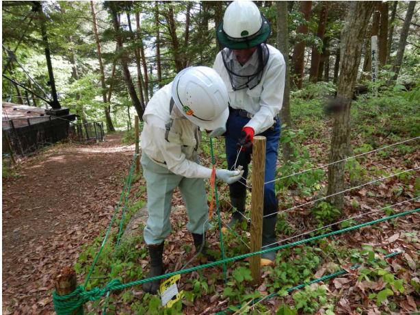
電気柵の設置作業
