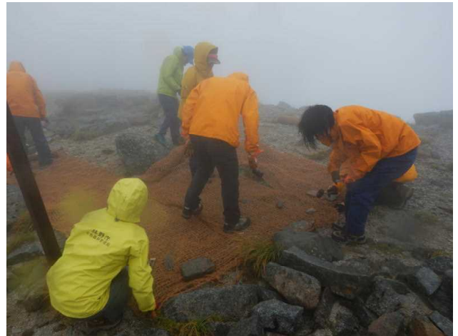
植生マット敷設作業
