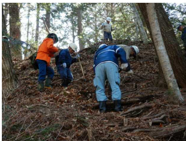
遊歩道の補修作業
