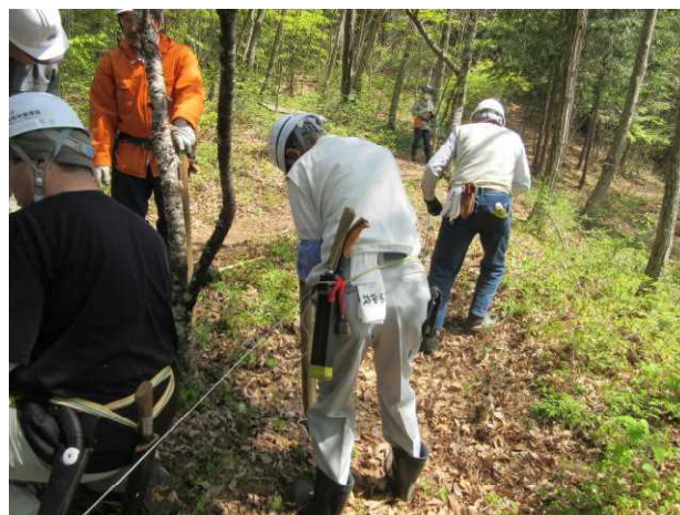
電気柵の設置作業
