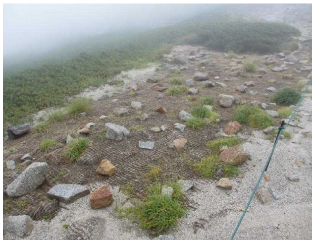
令和3年度の作業箇所の状況
