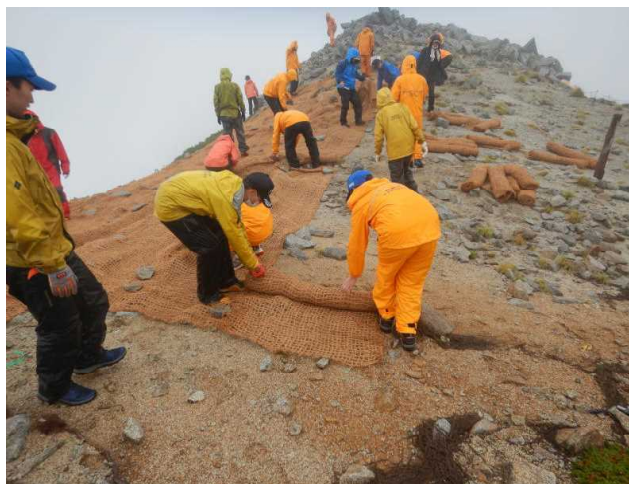
植生マットの敷設状況
