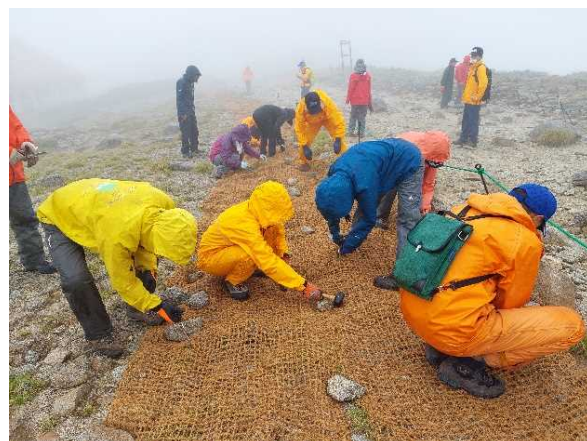
小雨の中での植生マット敷設作業
