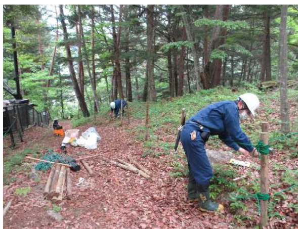
電気柵の設置（5月16日）
