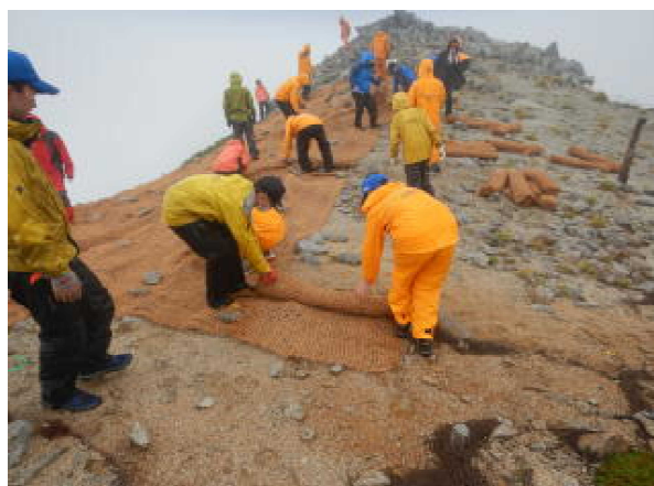
植生マットの敷設作業
