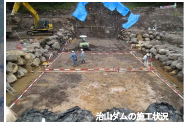
治山ダムの施工状況
