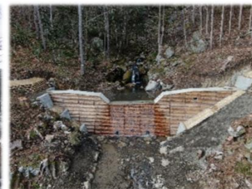
木祖村 溪間工
