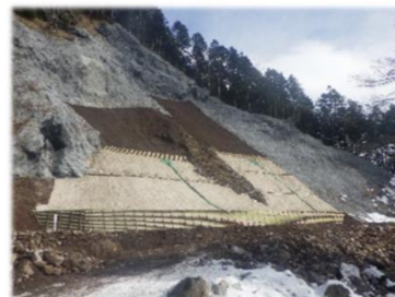
木曽町 山腹工
