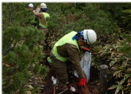
御嶽山麓の遊歩道(木道)整備の様子【王滝村】
