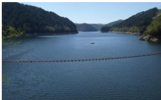
当地域は中京圏の重要な水源地 味噌川ダム【木祖村】など
