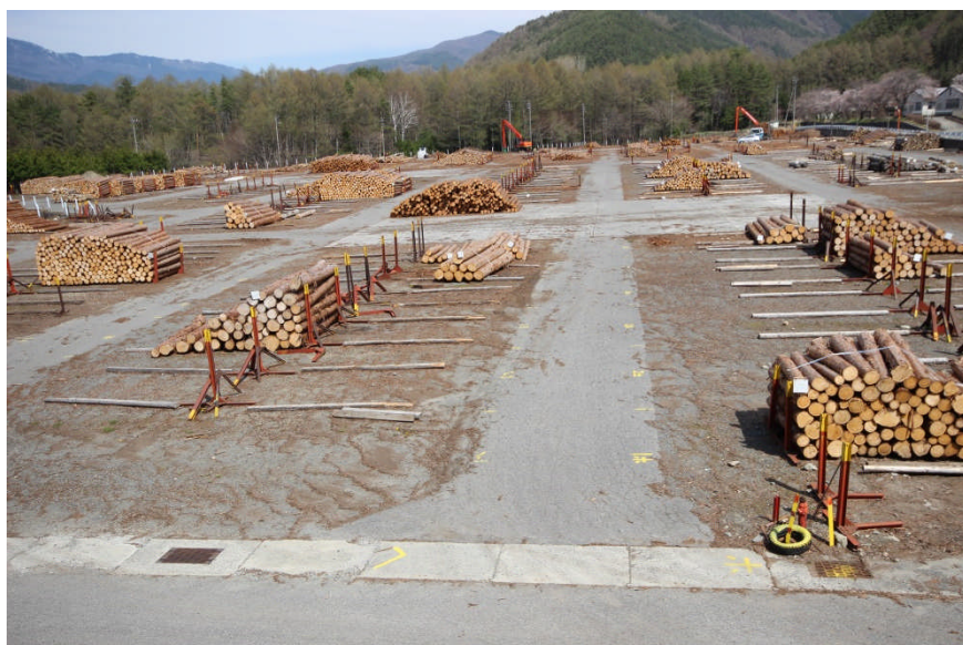
一部を貸付した国道 19 号沿線の藪原土場
