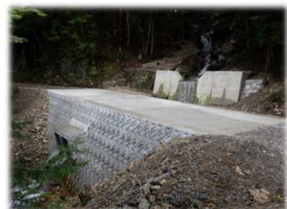
西沢林道改良工事
