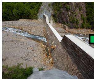
コンクリート谷止工による土砂捕捉状況
