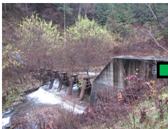
スリット谷止工による土石等の捕捉状況
