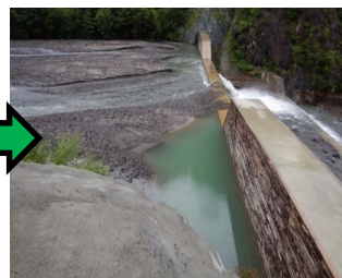
コンクリート谷止工による土砂捕捉状況
