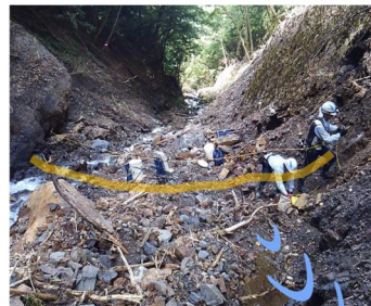
土石流センサー の設置 (日義国有林)
