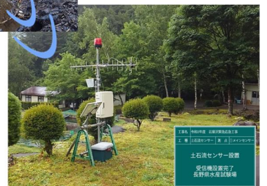
土石流センサー の設置 (日義国有林)
