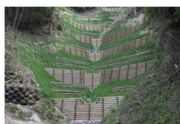
山腹工(東濃署)
