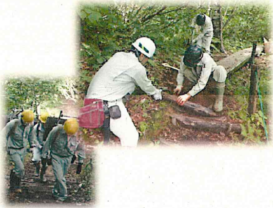
ボランティアによる県立自然公園の木道整備
