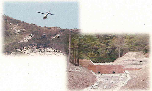
安全安心な国土を目的に、復旧治山工事の取り組み 左：山腹工 (高山市奥飛騨温泉郷 穂高国有林) 右：溪間工 (高山市荘川町 六廐川国有林)
