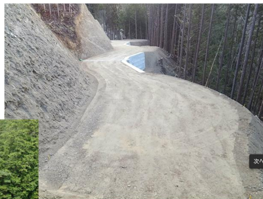
小ヌクイ大檜林業専用道新設工事
