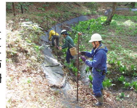
防護柵の設置 (山中山国有林)
