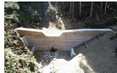
木製残存型枠を使用した谷止工 （大ハゲ復旧治山工事）
