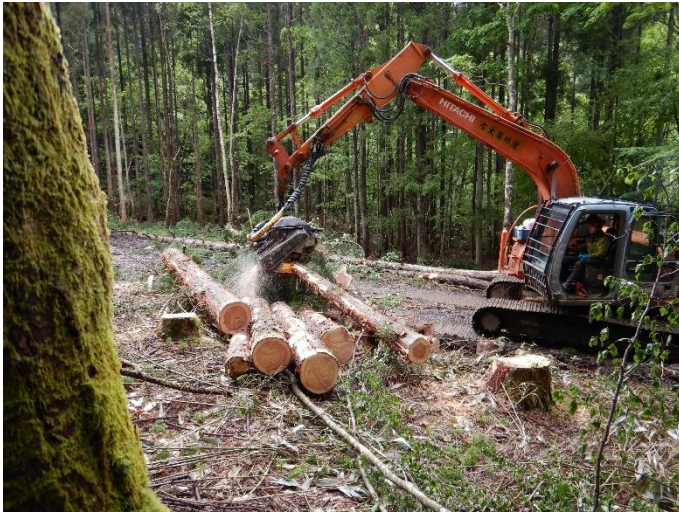
高性能林業機械による森林整備(造材作業)
