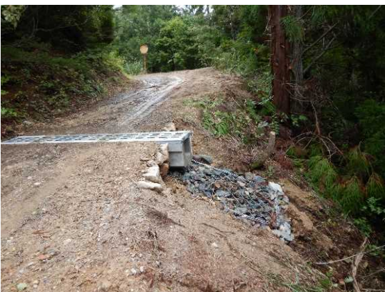
▲路体改良工事
