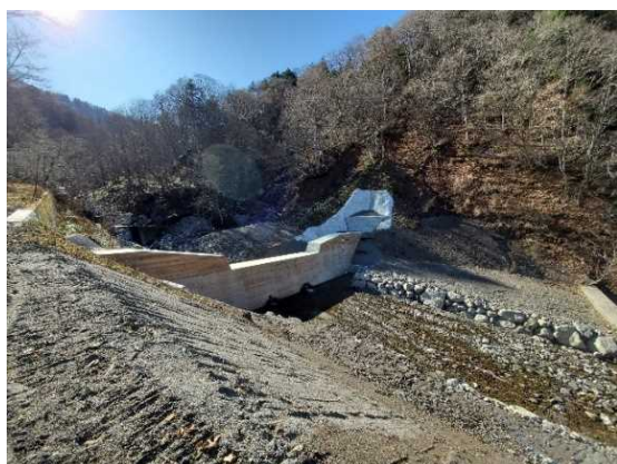
▲治山工事(福地国有林)
