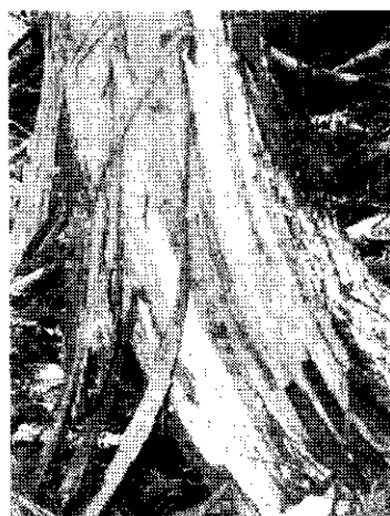
写真⑥ 完全劣化 被害有り
