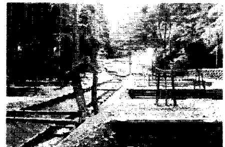
写真-4 渡合山腹工植栽後の写真
