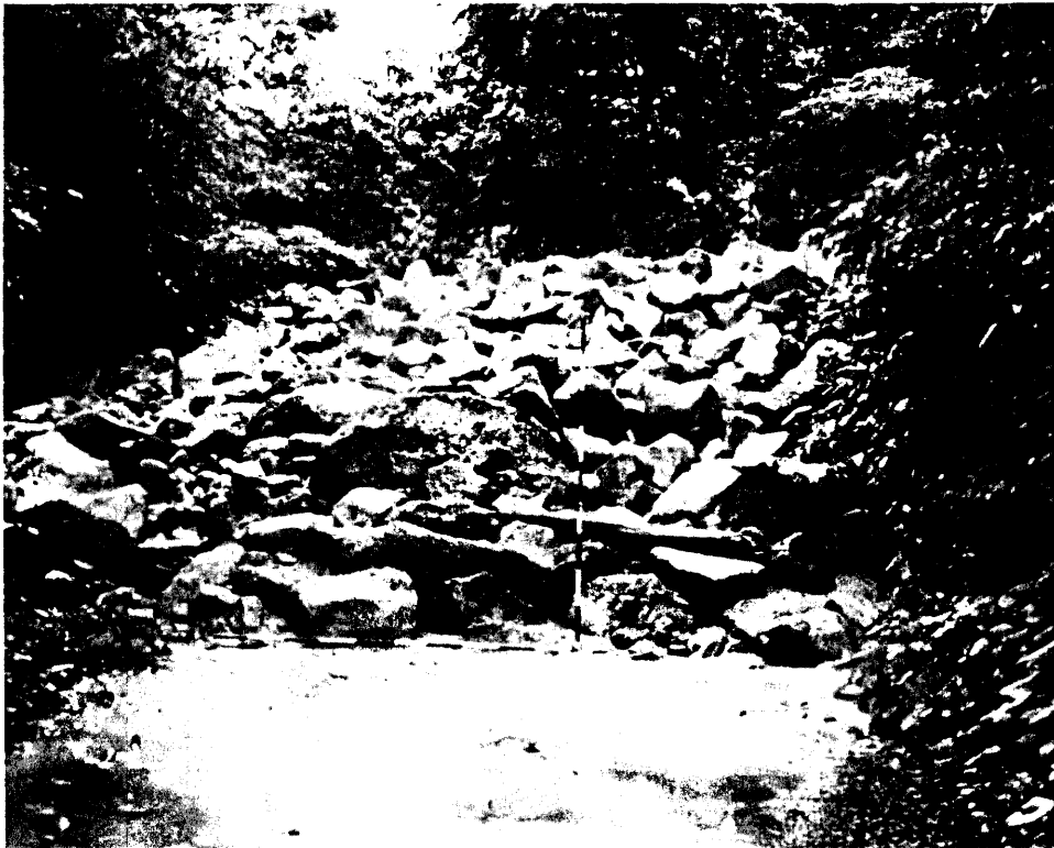
林道上の崩壊土砂
