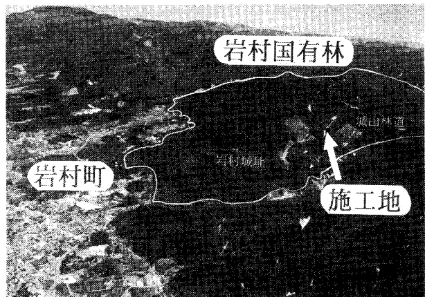
施工地の全景
