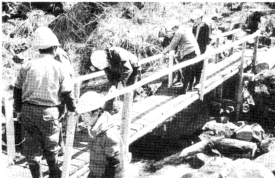
仙人滝滝見歩道の架橋作業
