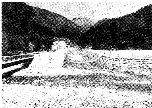
渓床・溪岸の整備状況
