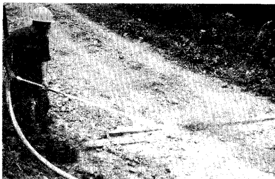
写真2 水圧ポンプによる横断溝の土砂除去作業
