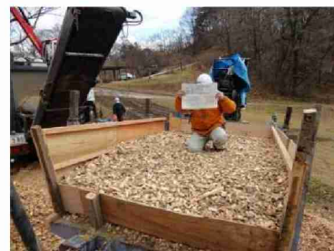
▲写真-4 丸太のチップ化後 (チップを均して、体積を確認。)
