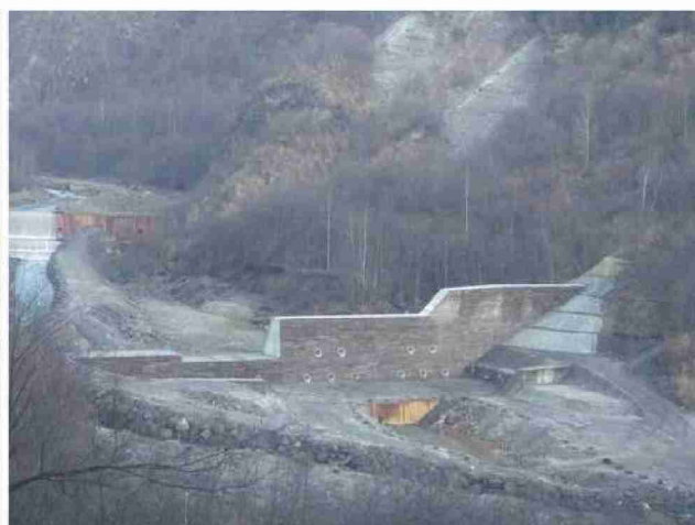
(平成28年度施工完了)
