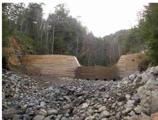
写真-28 (倉本湯川第1号コンクリート谷止工)
