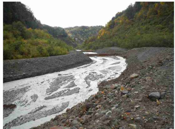
写真-6（除石完了下流方向）
