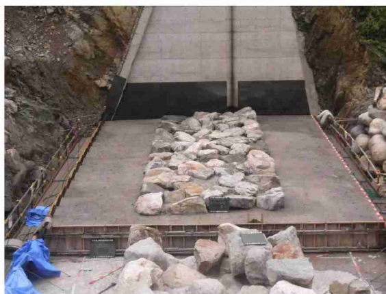
写真-7 打設完了の状況
