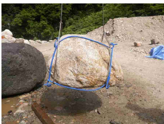
写真-4 鉄筋を加工した抜け落ち対策
