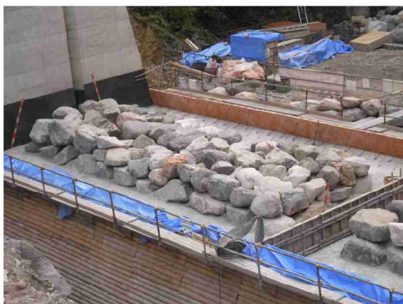
写真-6 設置完了の状況
