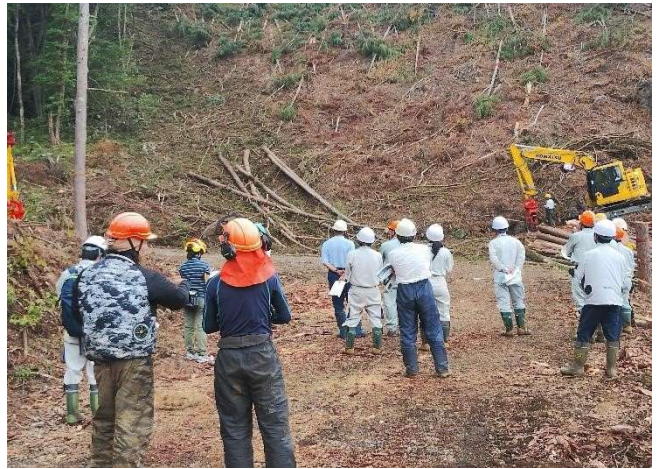
写真－７ 現場見学会開催の様子
