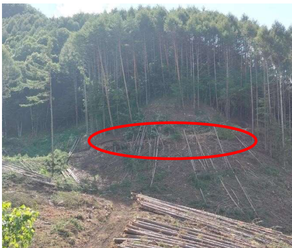
写真－2 森林作業道開設最終箇所
