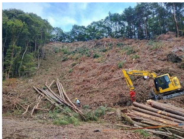
写真－5 グラップル付きBHのオペレーターが荷を外し、スイングヤーダのラジコン操作も兼務している
