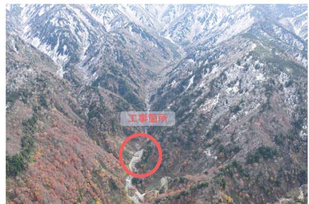
写真-1 工事箇所遠景写真
