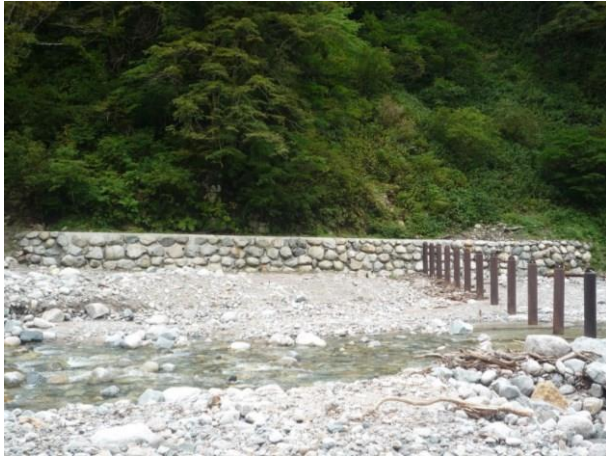
(写真4：左岸側の護岸工)
