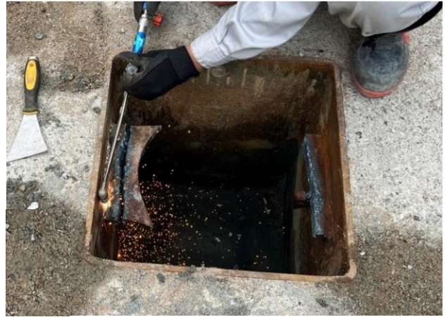
(写真9：CFT構造化の様子)
