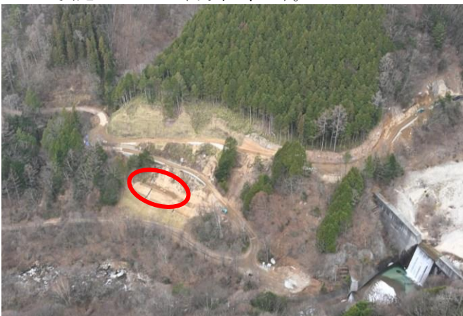
(写真2：施工場所)
