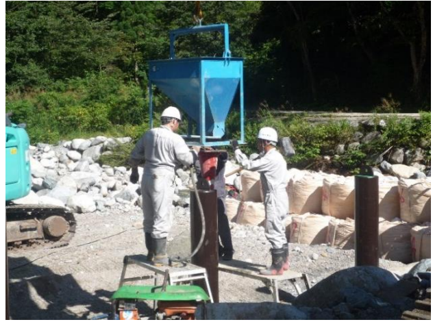
(写真8：CFT構造化の様子)
