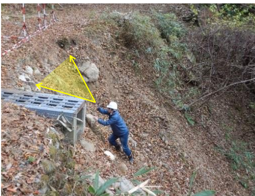
(写真3：崩壊地内での測量状況)
