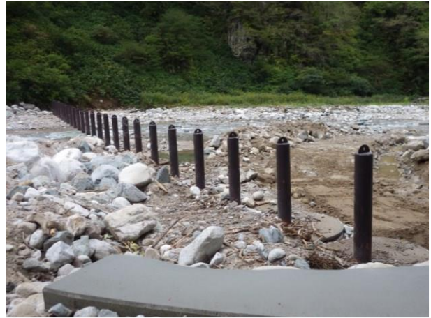
(写真5：流木撤去後の周辺状況)
