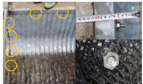
(写真4：設置時のネジ山利用)
