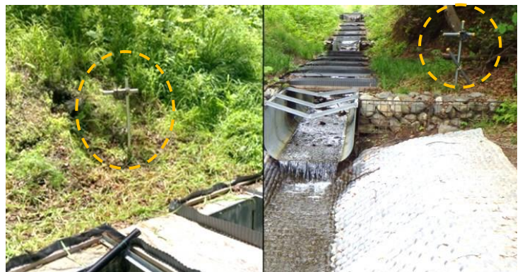
(写真6：定点カメラ設置状況)
