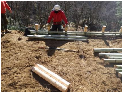
(写真7：横木の固定)
