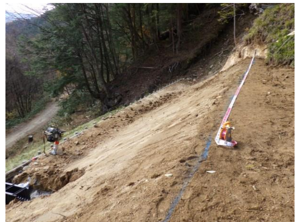
(写真3：施工場所近景)
