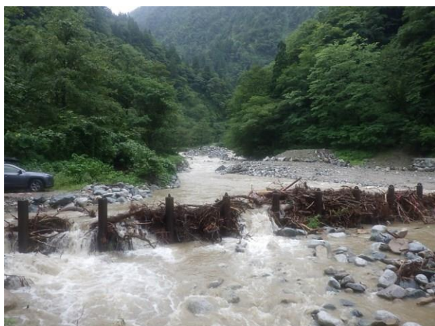
(写真10：令和7年の流木捕捉状況)
