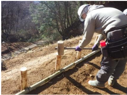
(写真6：杭木の打ち込み)
