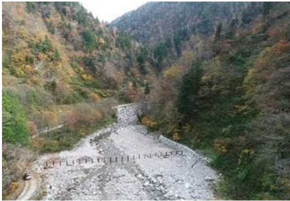
(写真1：設置箇所上流の状況)
