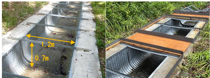
（写真1：既設水路）
