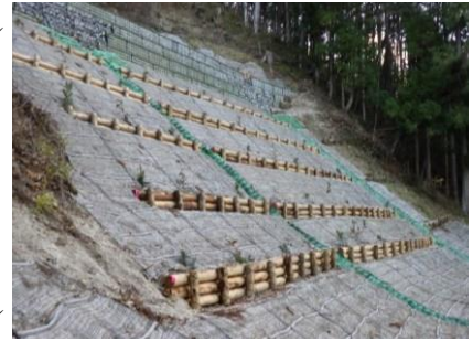
(写真1：丸太筋工)
