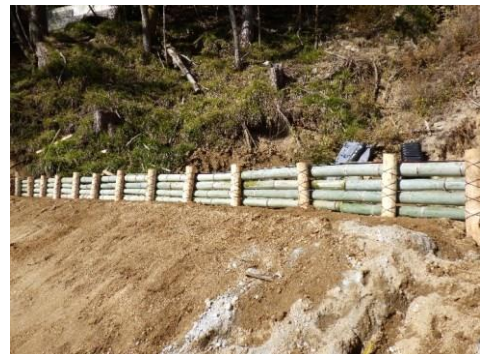
(写真10：竹筋工完成)
