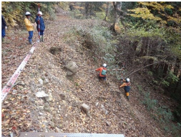
（写真2：ポール横断測量の様子）
