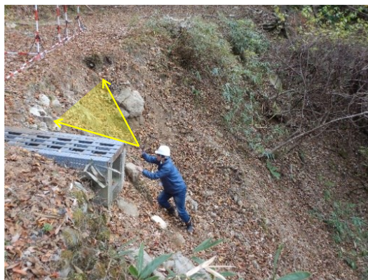
（写真3：崩壊地内での測量状況）
