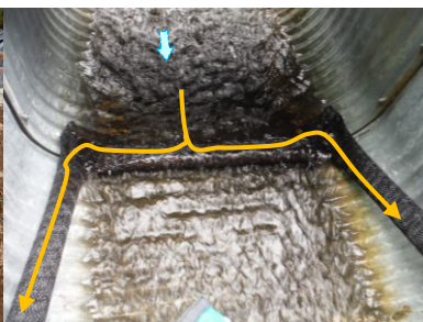
(写真3：網状パイプによる脱出スロープの設置)
