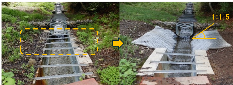
(写真5：側部緩傾斜水路への改修（前後状況）)
