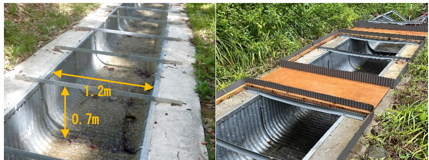
（写真1：既設水路）
