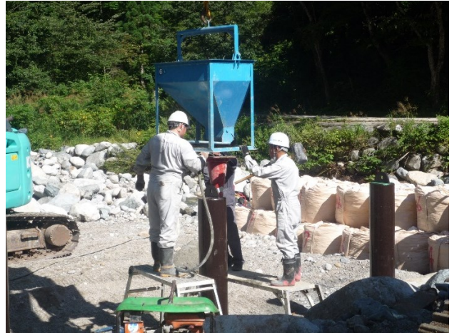
(写真8：CFT構造化の様子)
