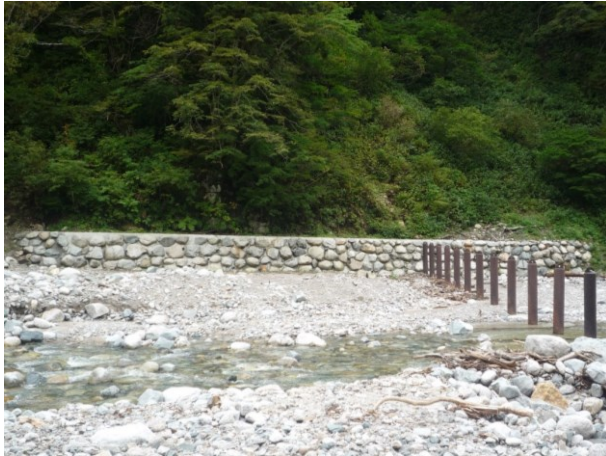
(写真4：左岸側の護岸工)
