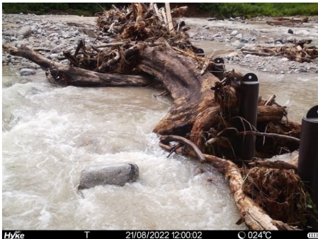
(写真2：流木捕捉状況)
