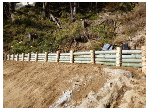
(写真10：竹筋工完成)
