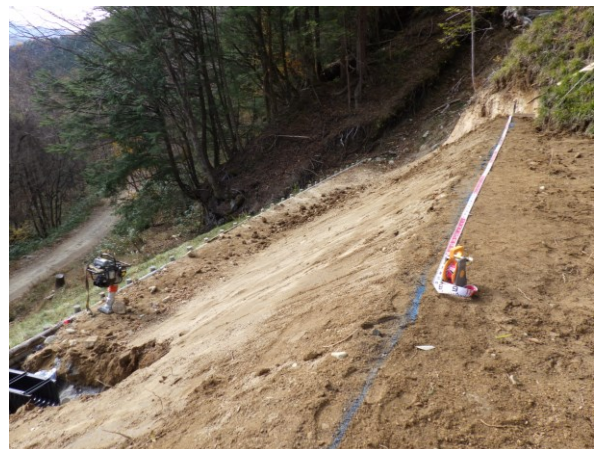
(写真3：施工場所近景)
