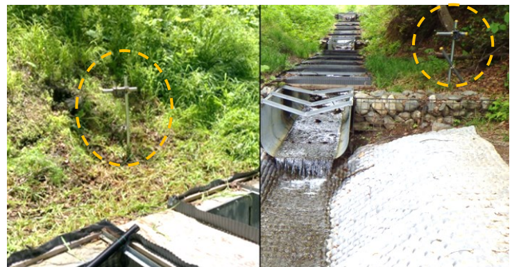
(写真6：定点カメラ設置状況)
