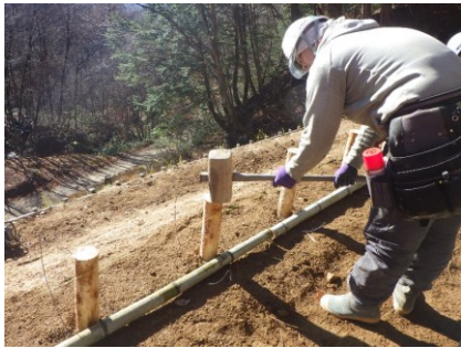
(写真6：杭木の打ち込み)
