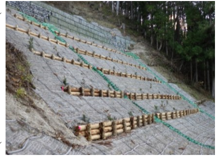
(写真1：丸太筋工)
