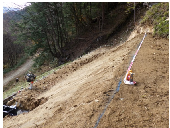
(写真3：施工場所近景)
