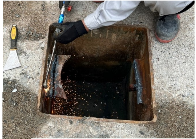
(写真9：CFT構造化の様子)
