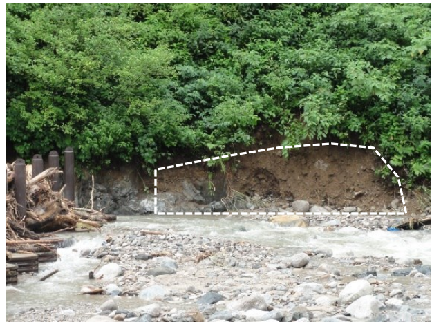
(写真3：左岸側の溪岸侵食)
