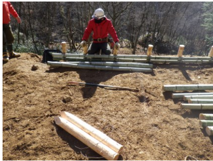
(写真7：横木の固定)
