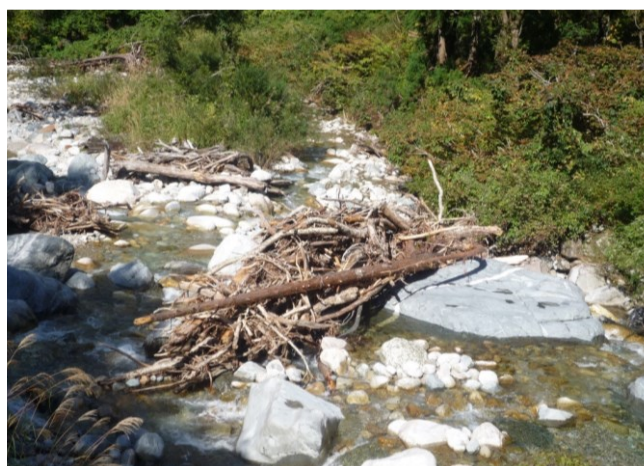
(写真11：上流の枯損木堆積状況)
