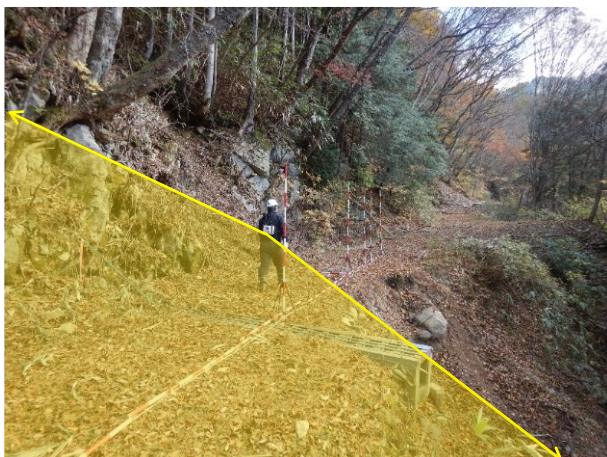
(写真4 : 林道上での測量状況)
