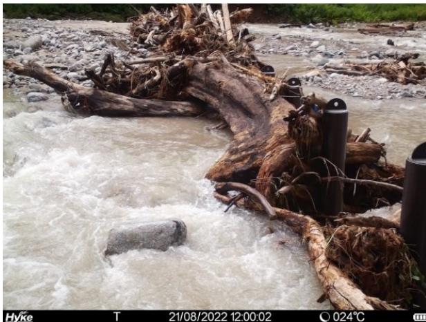
(写真2：流木捕捉状況)
