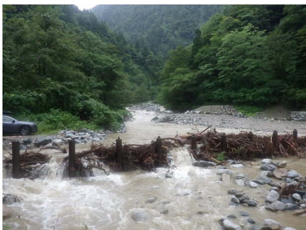
(写真10：令和7年の流木捕捉状況)
