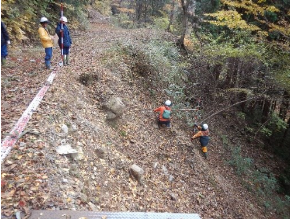
（写真2：ポール横断測量の様子）
