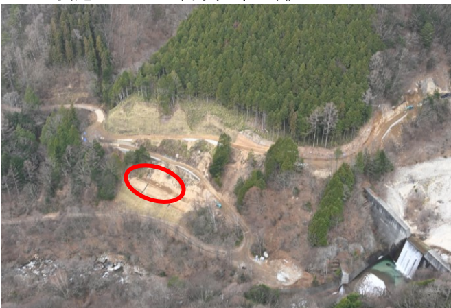
(写真2：施工場所)
