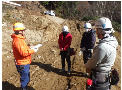
(写真5：施工前の打合せ)
