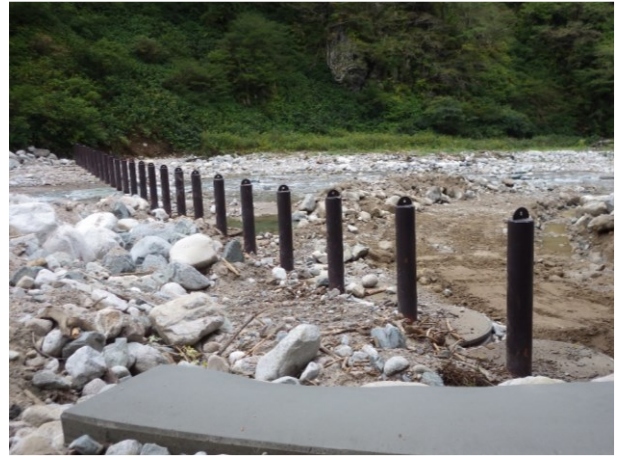
(写真5：流木撤去後の周辺状況)
