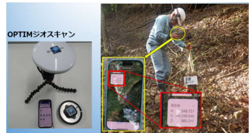
写真－1 3次元起工測量
