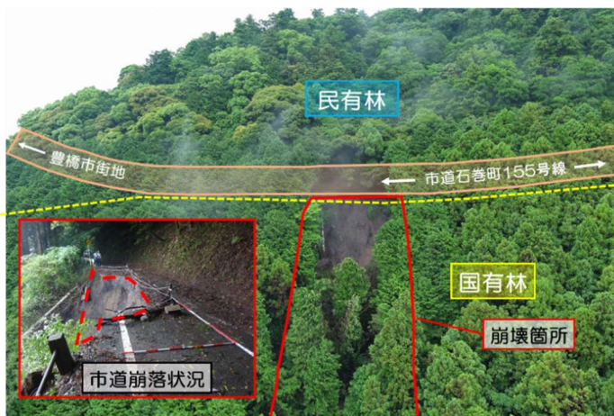
写真－７ 山腹崩壊および市道崩落状況
