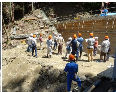
写真－３ 施工中の現場での説
