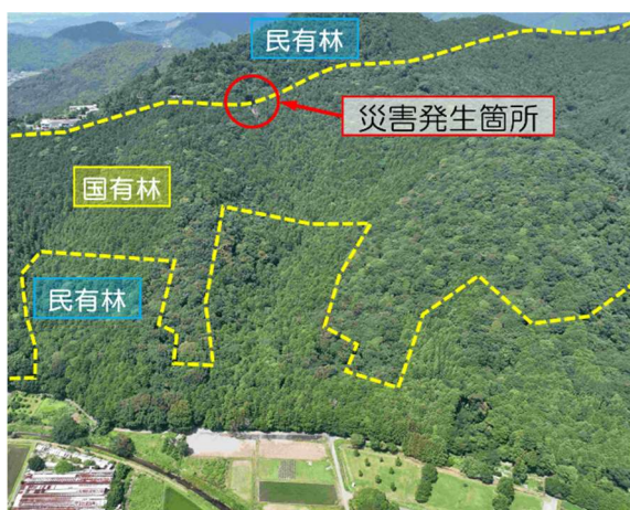
写真－６ 山腹崩壊遠景
