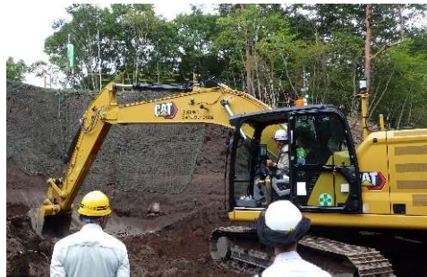
写真－3 ICT建機による施工の様子
