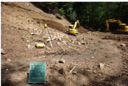
写真-8 ICT建設機械による掘削
