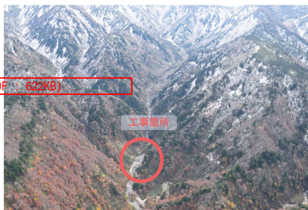
写真-1 工事箇所遠景写真
