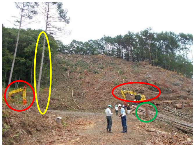
写真－3 左側赤○印スイングヤード 右側赤○印グラップル付きBH 黄色○印ガイドツリー（向柱） 緑○印 ヘッドツリー（元柱）
