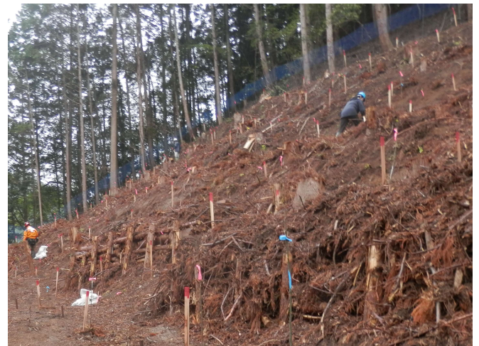
写真ー5 植栽状況（豊田市小渡町）
