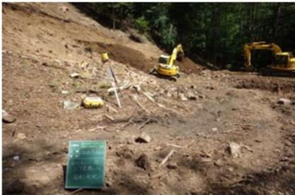
写真-8 ICT建設機械による掘削
