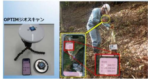
写真-1 3次元起工測量
