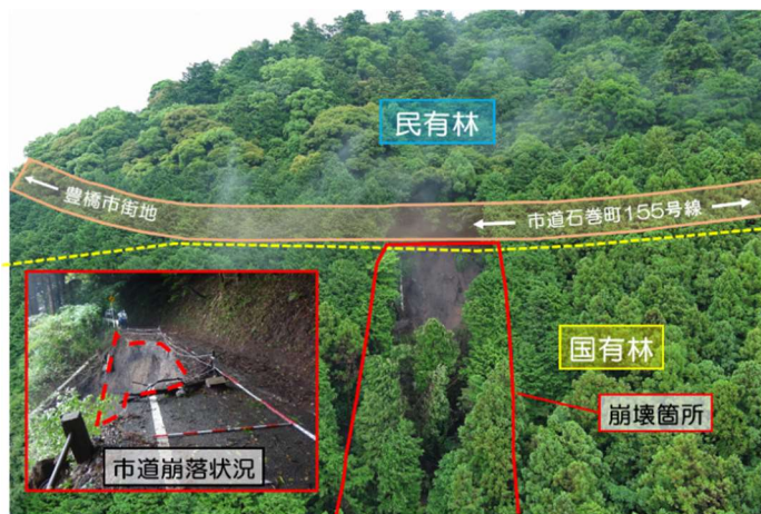
写真－７ 山腹崩壊および市道崩落状況
