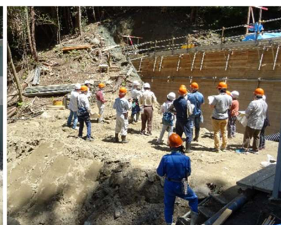
写真－３ 施工中の現場での説明
