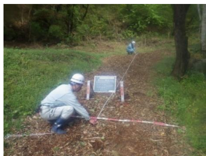
▲写真 4 チップ容積の確認 (施工出来形確認)
