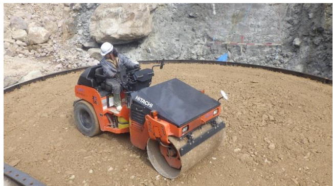
写真－6 振動ローラ転圧状況
