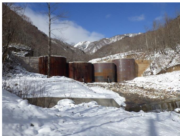
写真－8 工事完成状況 2
