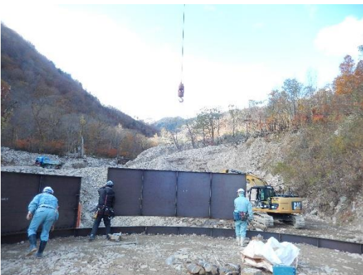
写真－5 鋼板セル組立状況
