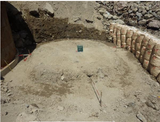
写真－3 床掘状況
