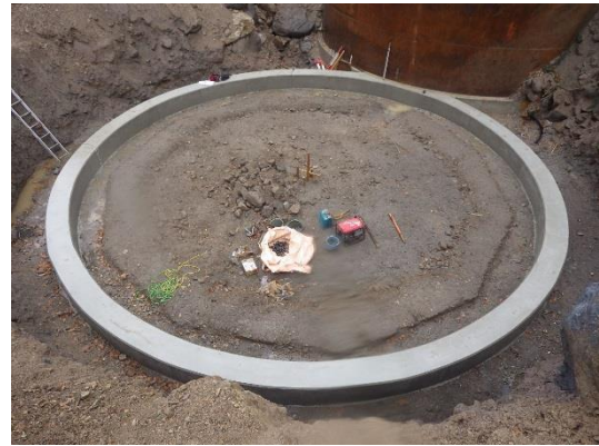
写真－4 基礎コンクリート打設
