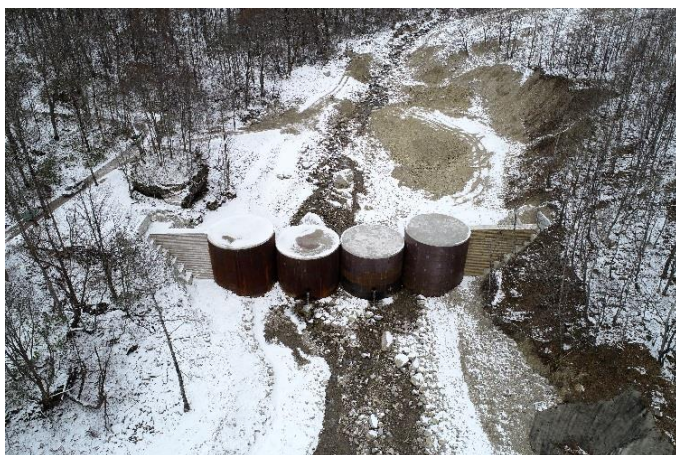
写真－7 工事完成状況 1
